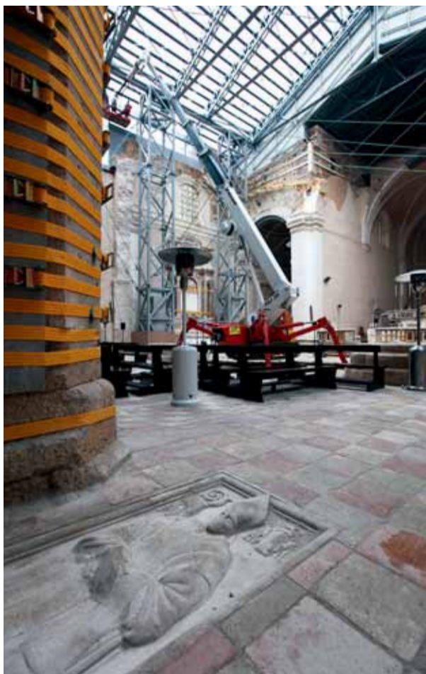
Fig. 2. L'Aquila, basilique de Collemaggio, couverture provisoire du transept.
