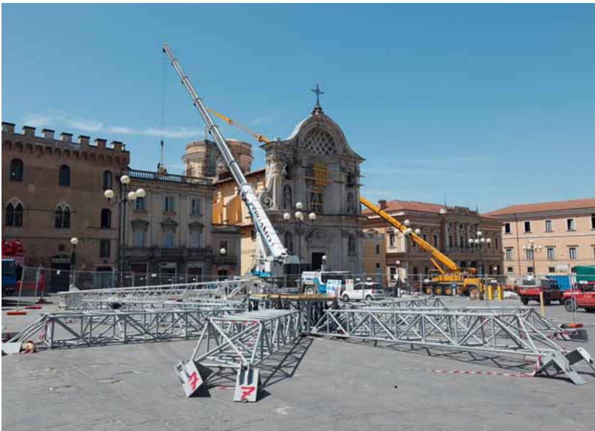
Fig. 8. Vue de l'araignée de soutènement du dôme avant sa mise en place dans l'église Santa Maria del Suffragio.
