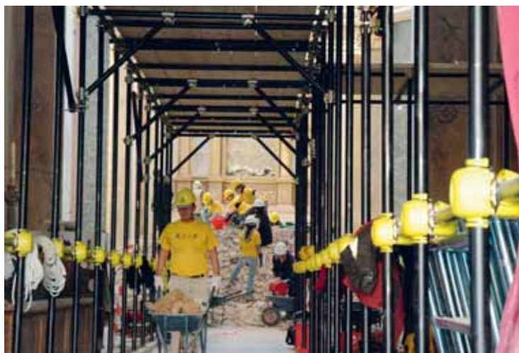
Fig. 11. L'Aquila, église Santa Maria del Suffragio dite delle Anime Sante , vue du tunnel en bois de charpente et tubes d'échafaudages.
