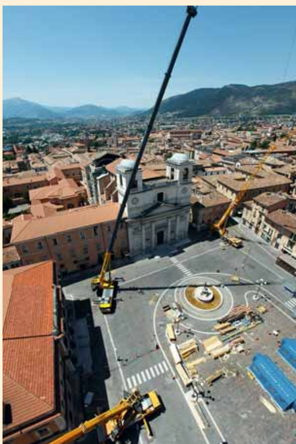
Fig. 1. L'Aquila, vue de la cathédrale et de la Piazza Duomo, travaux de mise en sécurité.
